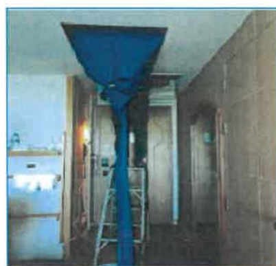
ภาพถ่ายที่ 2.2-31 การทำความสะอาดระบบปรับอากาศและระบบระบายอากาศ
